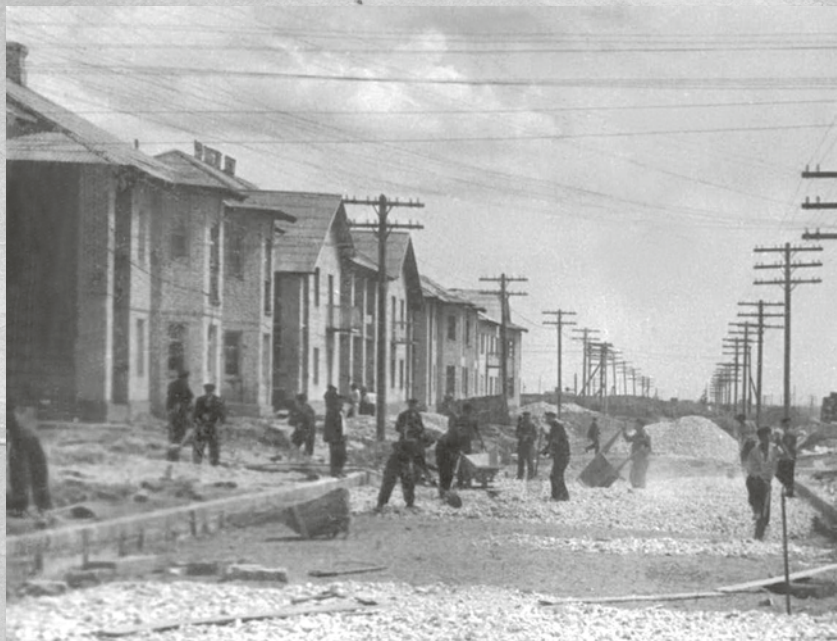
Строительство дороги между 1 и 2 кварталами. Июнь 1952 г.
