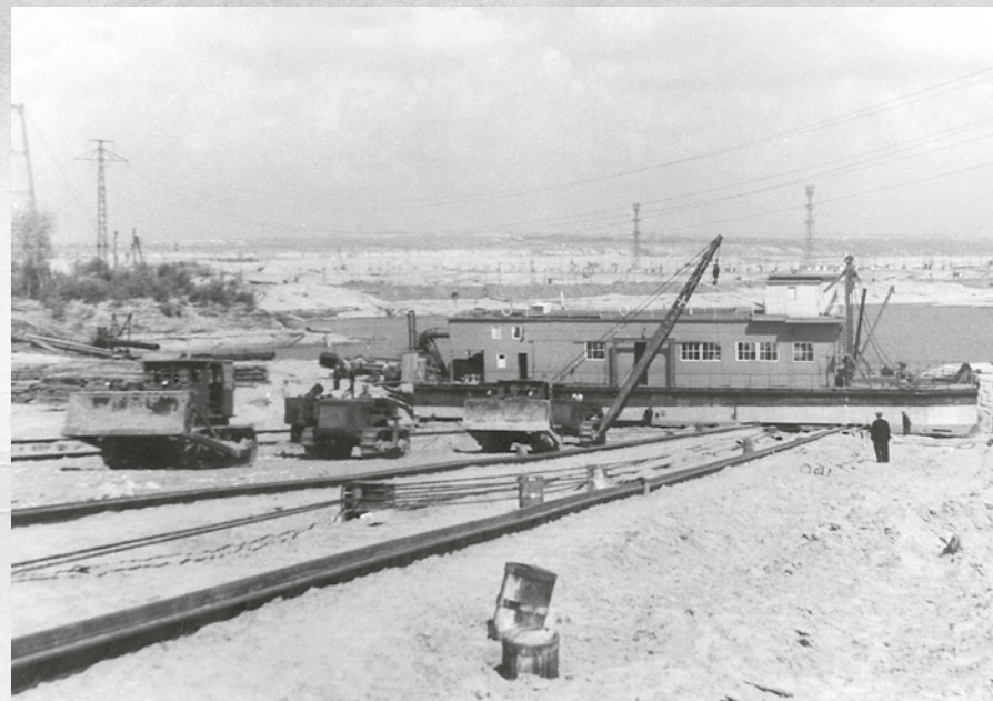
Перетаскивание земснаряда из котлована ГЭС в Волгу по суше. 1953 год
