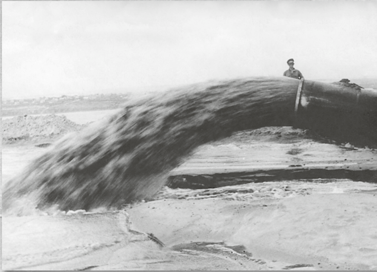
Безэстакадный намыв грунта. 1954 год
