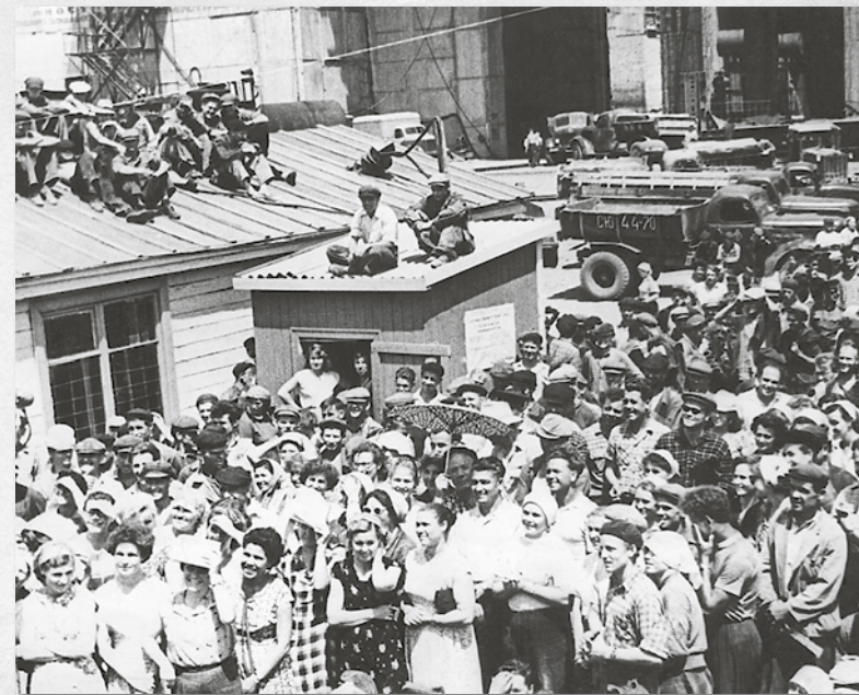
Концерт для строителей в котловане Сталинградской ГЭС в обеденный перерыв. 1950-е годы
