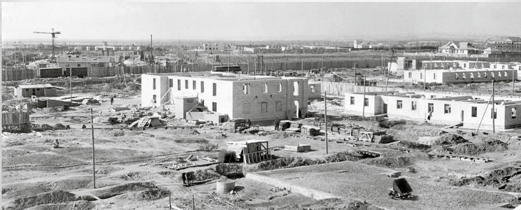
Начало строительства п. Волжского
