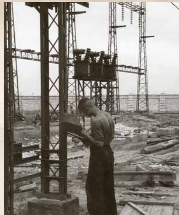
Монтаж подстанции № 2 в п. Волжском. Июль 1952 года
