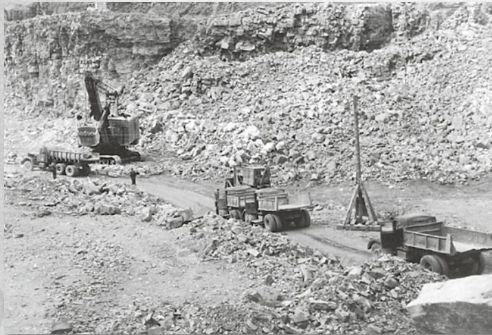
Выемка грунта из котлованов ГЭС и водосливной плотины сухим способом. 1953 год
