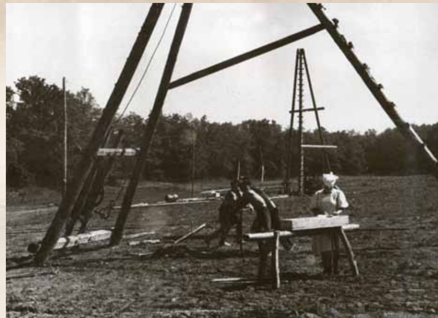
Буровые изыскательные работы на месте будущей водосливной плотины Сталинградского гидроузла
