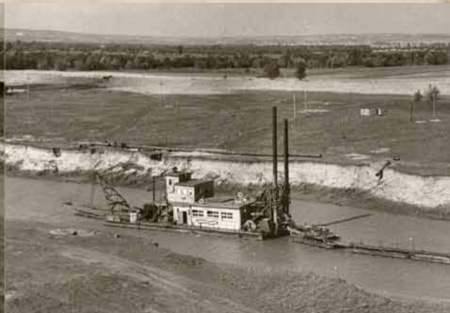
Панорама строительства Волго-Ахтубинского канала. Земснаряд № 322 в забое. 2 сентября 1952 года
