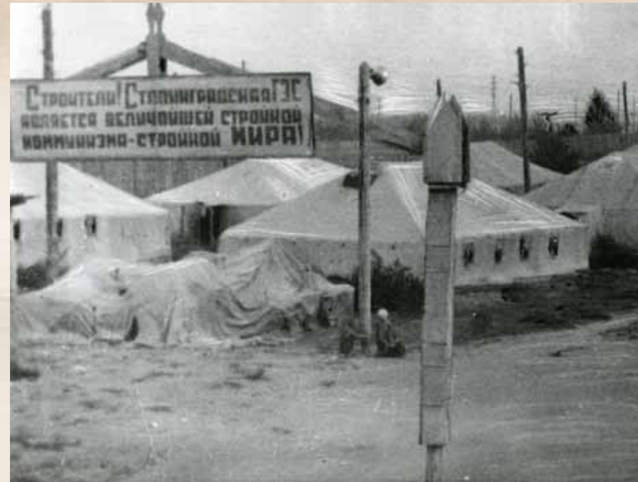
Палаточный городок на строительстве Сталинградской ГЭС.
