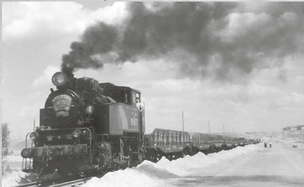
Первый поезд на низовой перемычке котлована ГЭС. Июль 1953 г.tif
