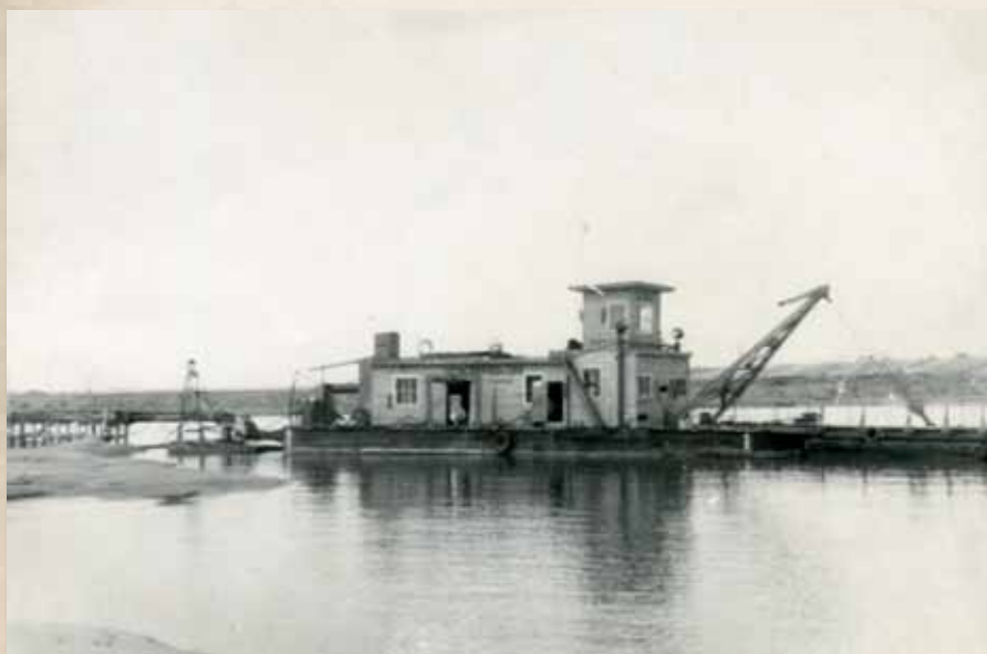
Земснаряд № 502 на строительстве Сталинградской ГЭС
