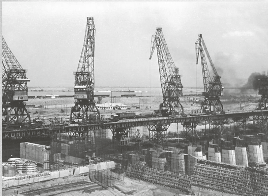
Общий вид бетоновозной эстакады. 1950-е годы
