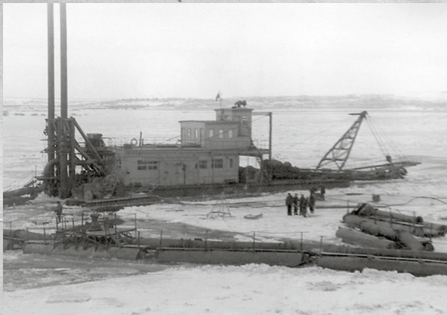
Работа земснаряда в зимних условиях
