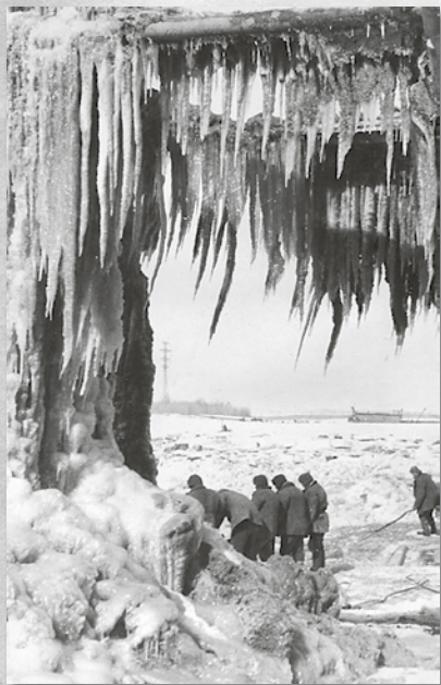
Панорама эстакады для укладки труб во время зимнего намыва. 1953 года
