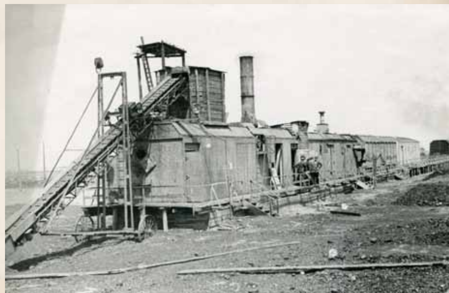
Первый энергопоезд на строительстве Сталинградской ГЭС. 1952 год
