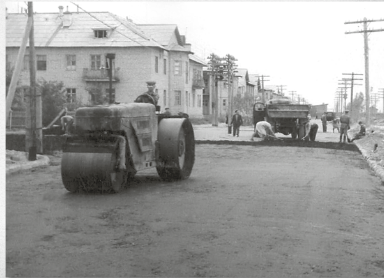
п. Волжский. Асфальтирование дороги на 6-й улице. Август 1953 г. Фото Н.Новак, П. Керсиков
