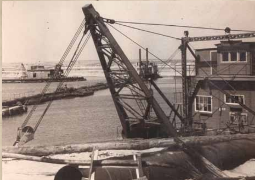
Земснаряды 1000-80 и 500-60 в забое под котлован ГЭС и плотину. Август 1952 года
