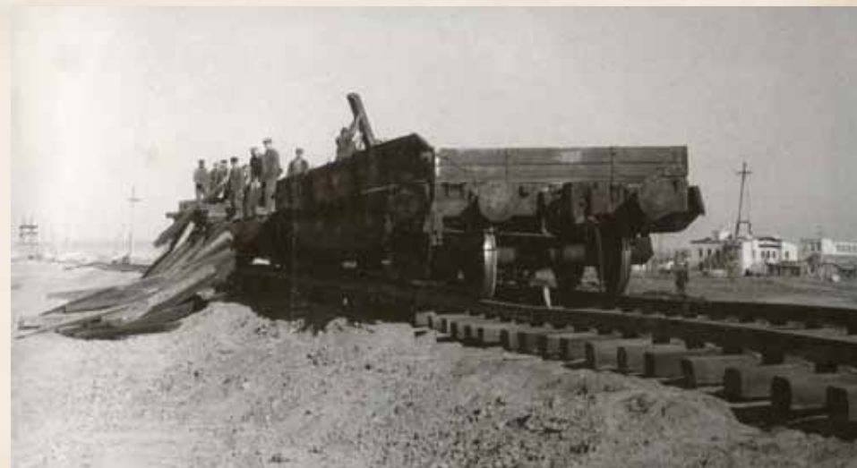
Строительство железнодорожных путей на левом берегу Волги. 1950-е годы
