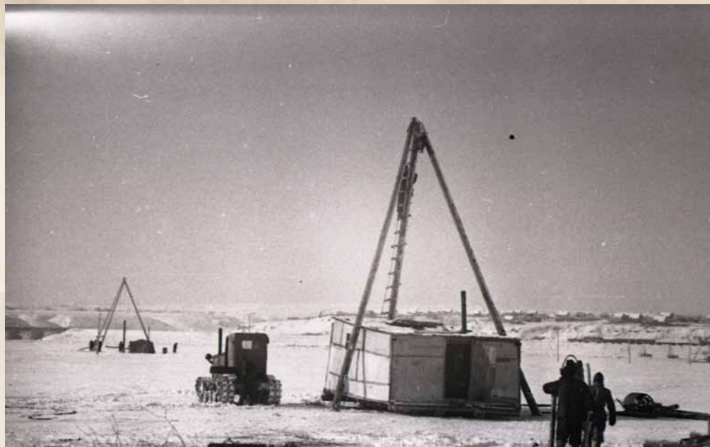
Первые буровые вышки на строительстве Сталинградской ГЭС
