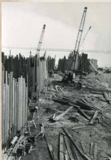
Остров Песчаный. Работы по возведению шпунтовой перемычки
