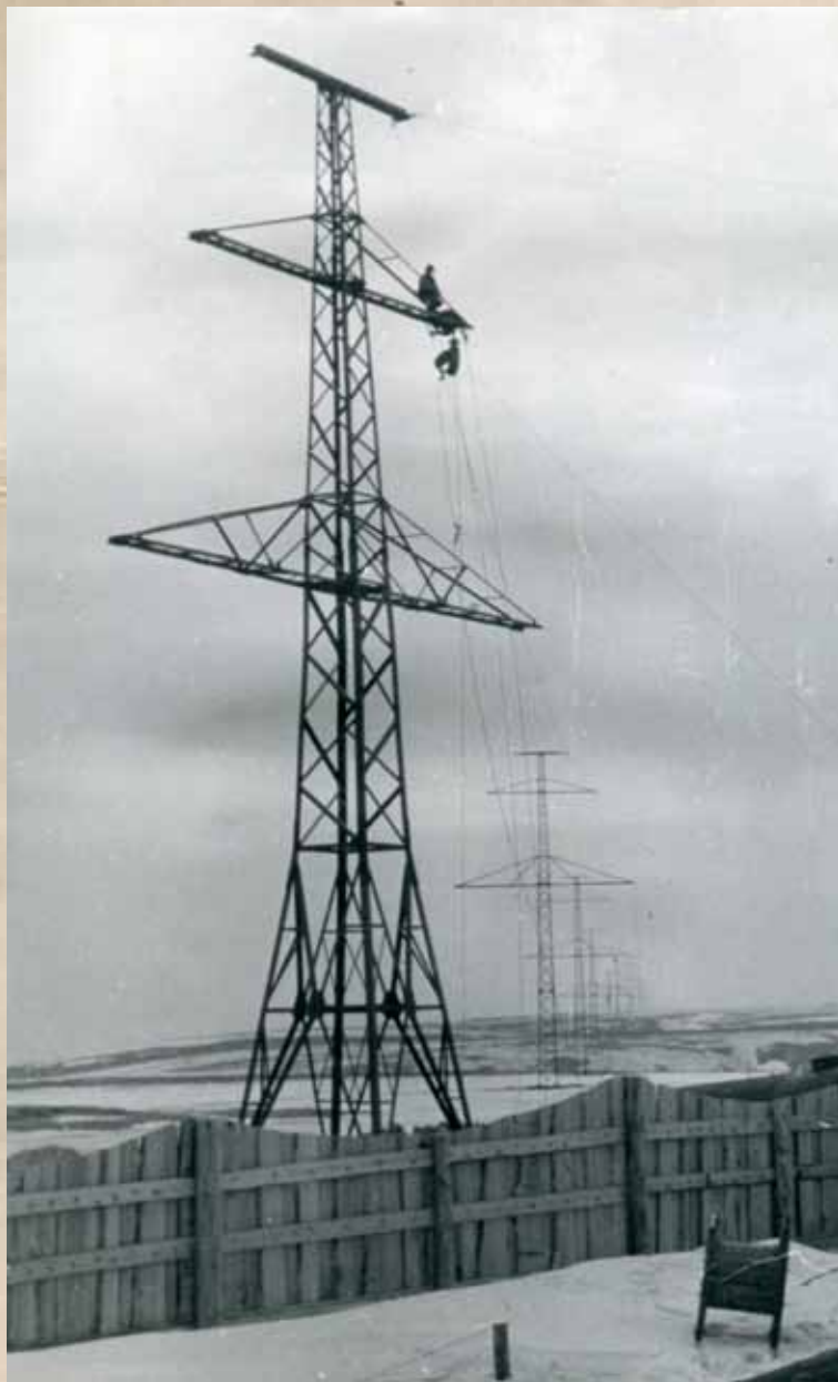
Строительство ЛЭП-110 кВт. Апрель 1953 год
