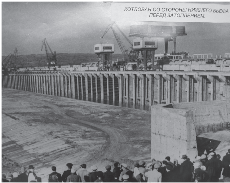
14 октября 1967 года. Котлован перед затоплением.
