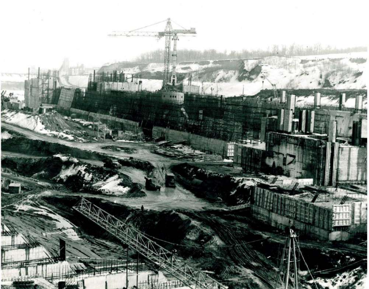
Строительство шлюза. Вид со стороны гидростанции. 1979 год.
