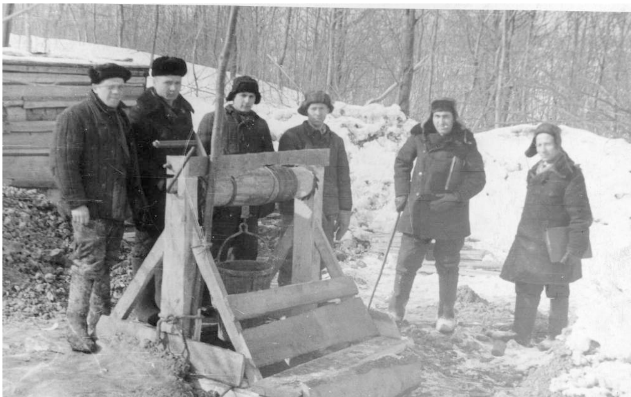
Правый берег Волги у устья Цыганкасинского оврага. Проходка шурфа вручную глубиной 20м с венцовым креплением. 1970 год.
