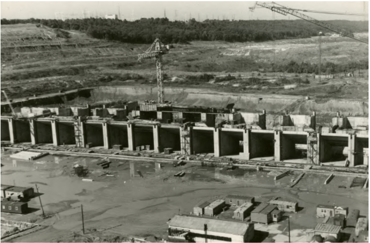
Здание ГЭС. Первый ярус готов. 1976 год.
