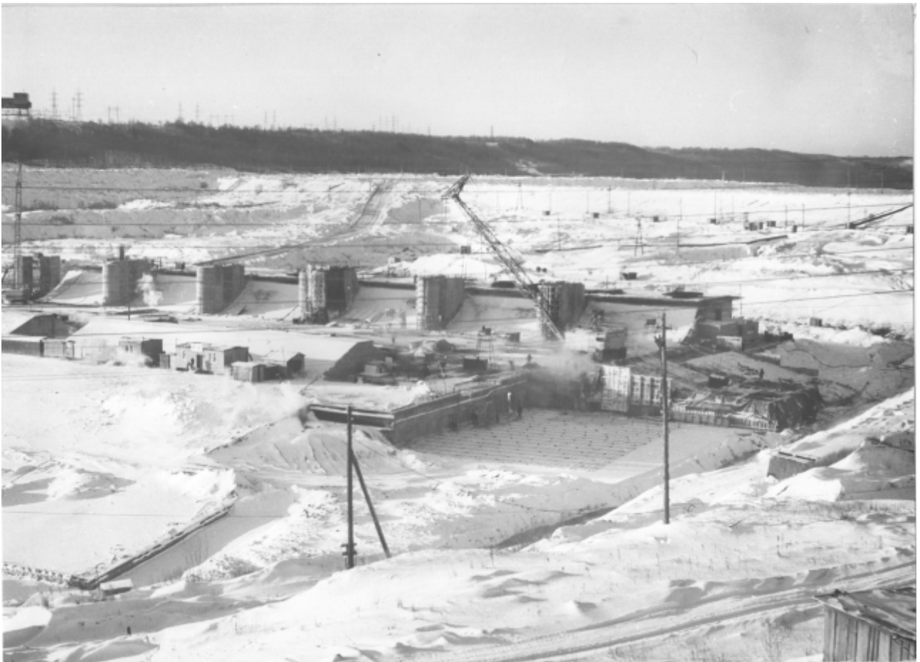
Строительство водосливной плотины. 1979г.
