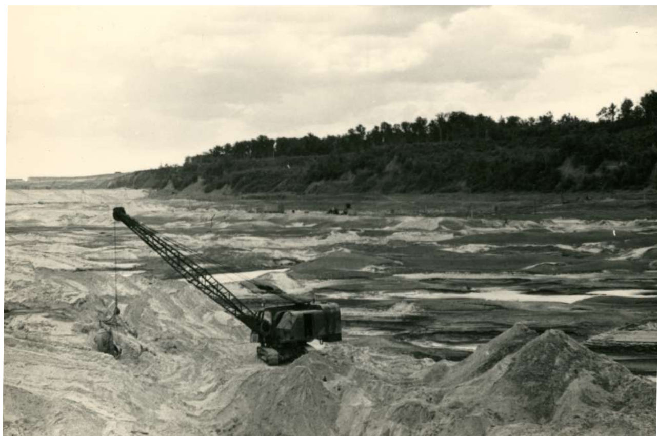
Проходка водосборных канав по периметру перемычек. 1969 год.
