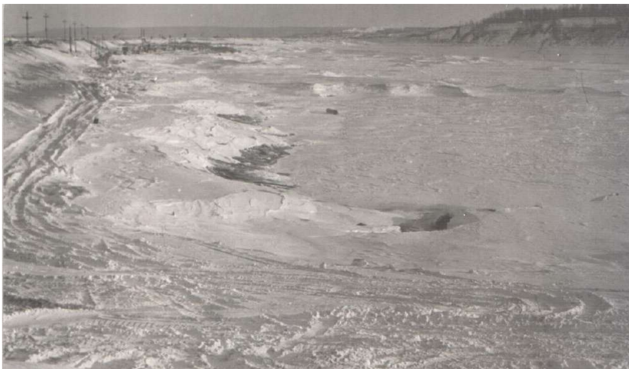
Просачивание волжской воды через тело перемычки. 1969 год.
