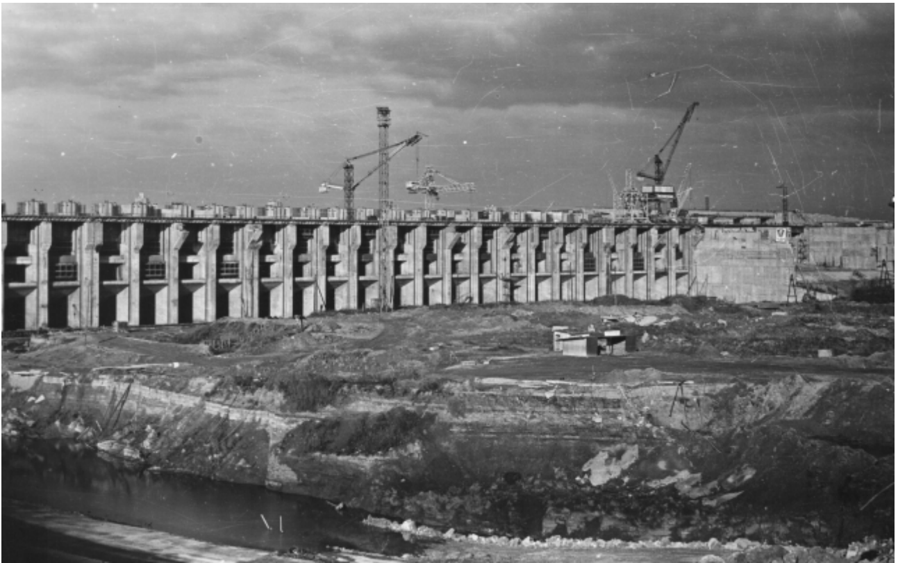
Котлован перед затоплением. 1980 год.
