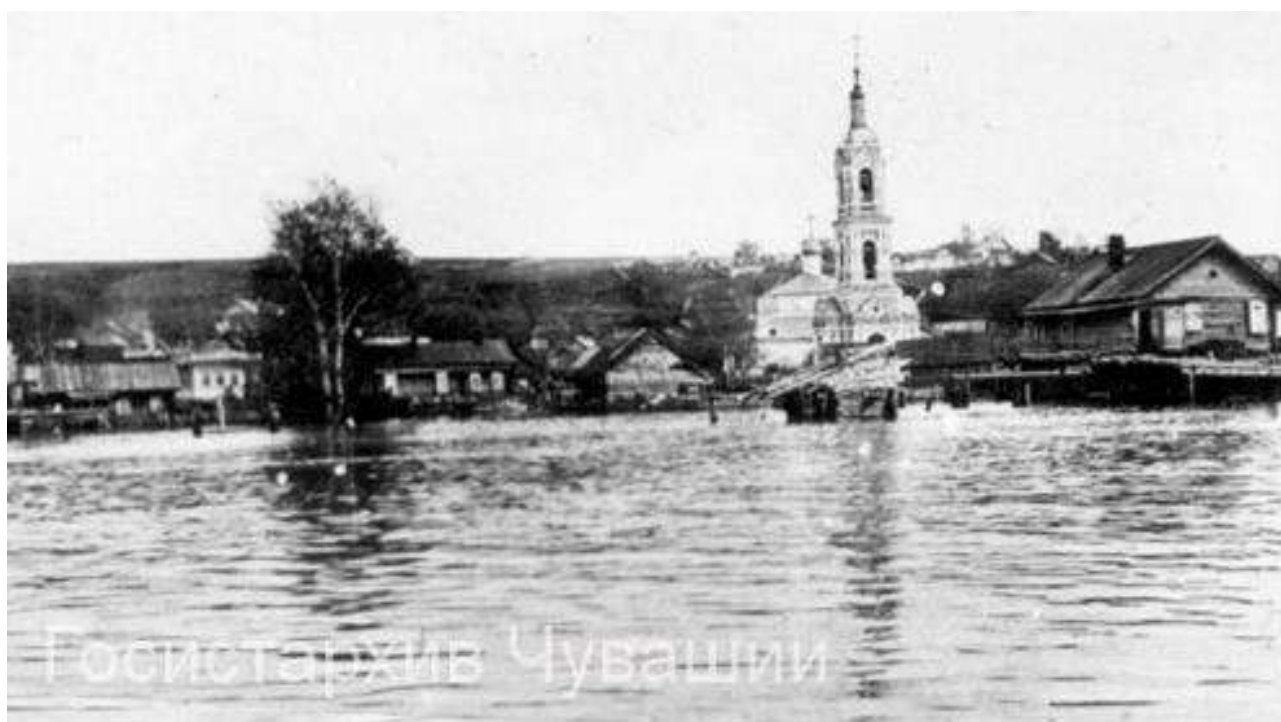
Половодье 1926 года в Чебоксарах. Вид на улицу Набережную и Крестовоздвиженскую церковь. Эта церковь, попадающая в зону затопления, была распилена на отдельные блоки и вывезена для дальнейшей сборки.
