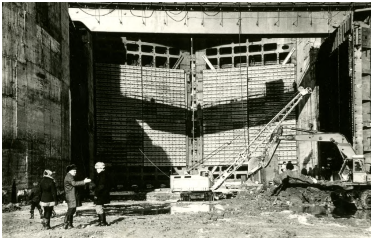
Шлюз. Нижняя голова. Всё готово к затоплению котлована. 1980 год.
