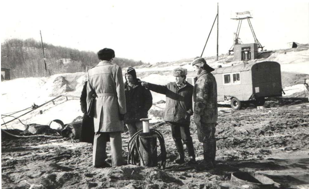
Котлован первой очереди. Монтаж системы глубинного водопонижения. Второй справа – Сергей Егоров. 1971 год.
