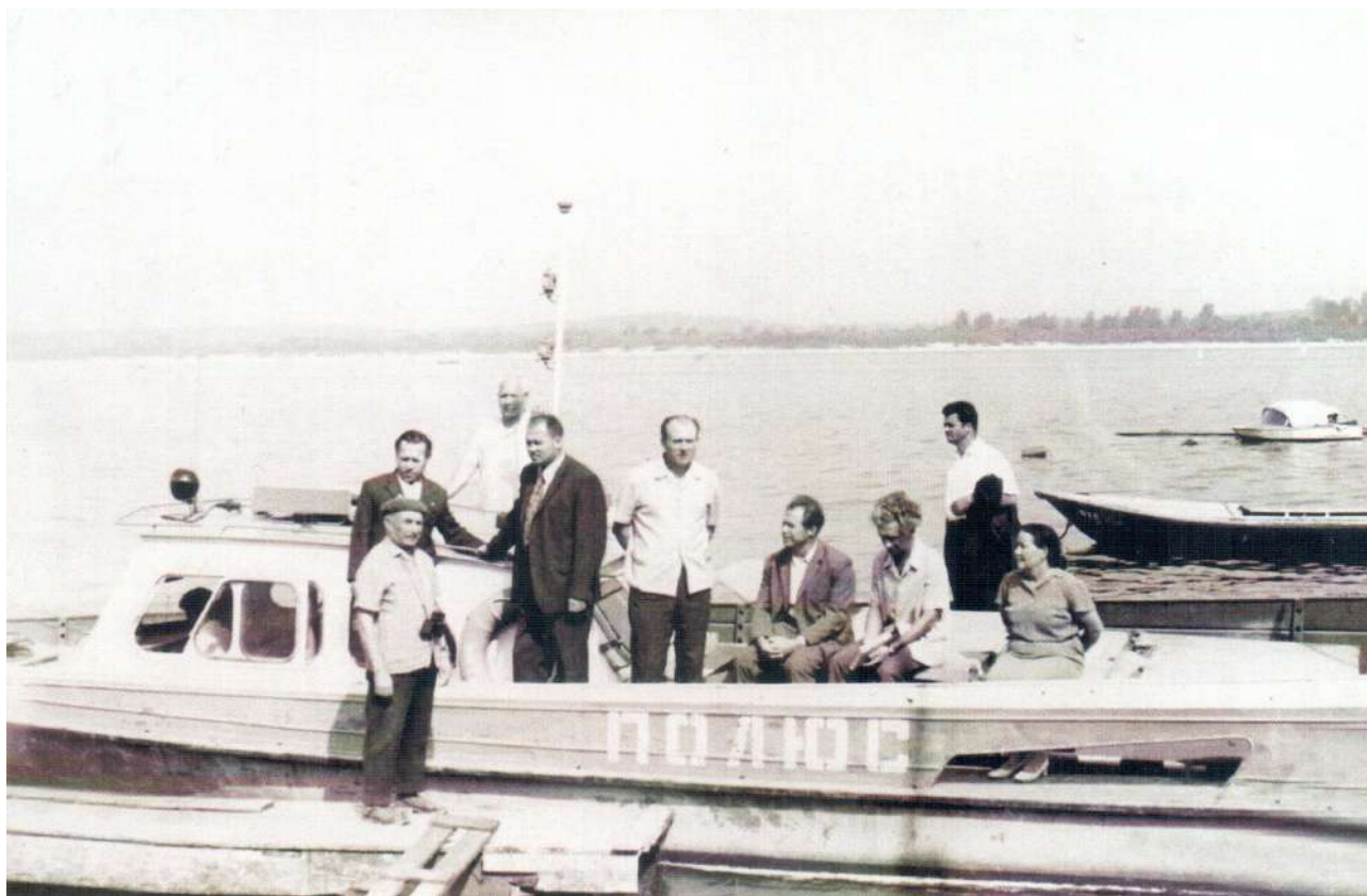
Выездное заседание рабочей комиссии по защите г.Чебоксары от влияния Чебоксарского водохранилища. Четвёртый справа - начальник отдела по подготовке зоны затопления при Совмине ЧАССР Василий Петрович Глуханьков. 1972 год.
