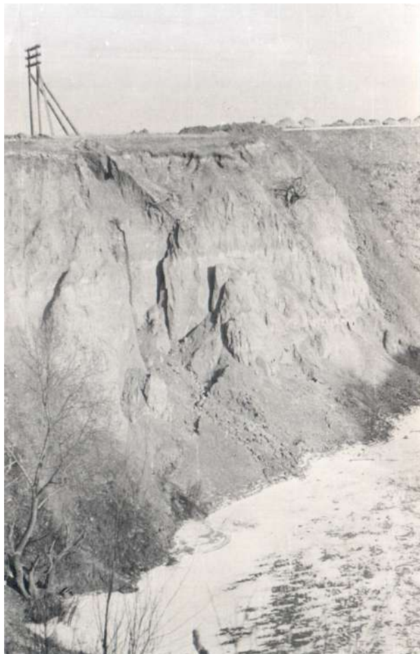
Начало работ по строительству Чебоксарской ГЭС. 1968-1970 годы. Намыв перемычек под будущий котлован гидромеханизированным способом.
