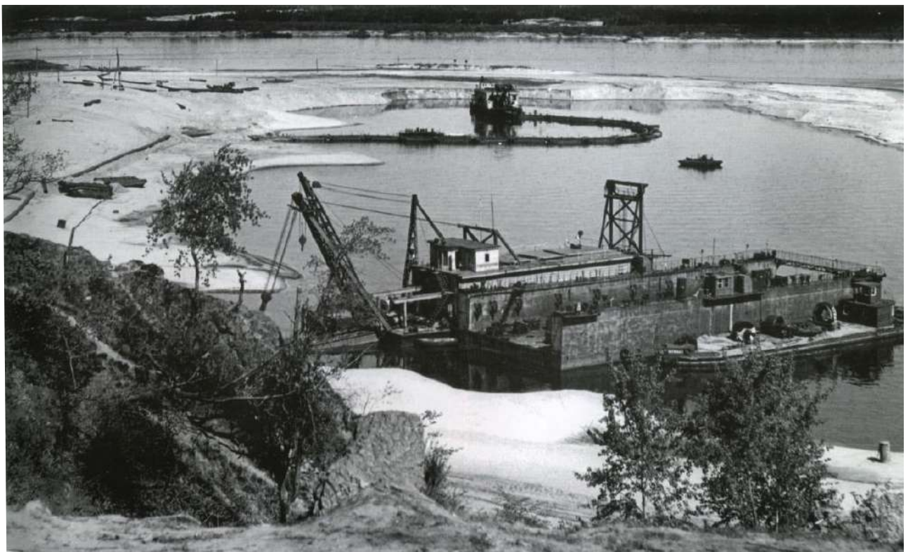
Откачка воды земснарядами. 1969 год.
