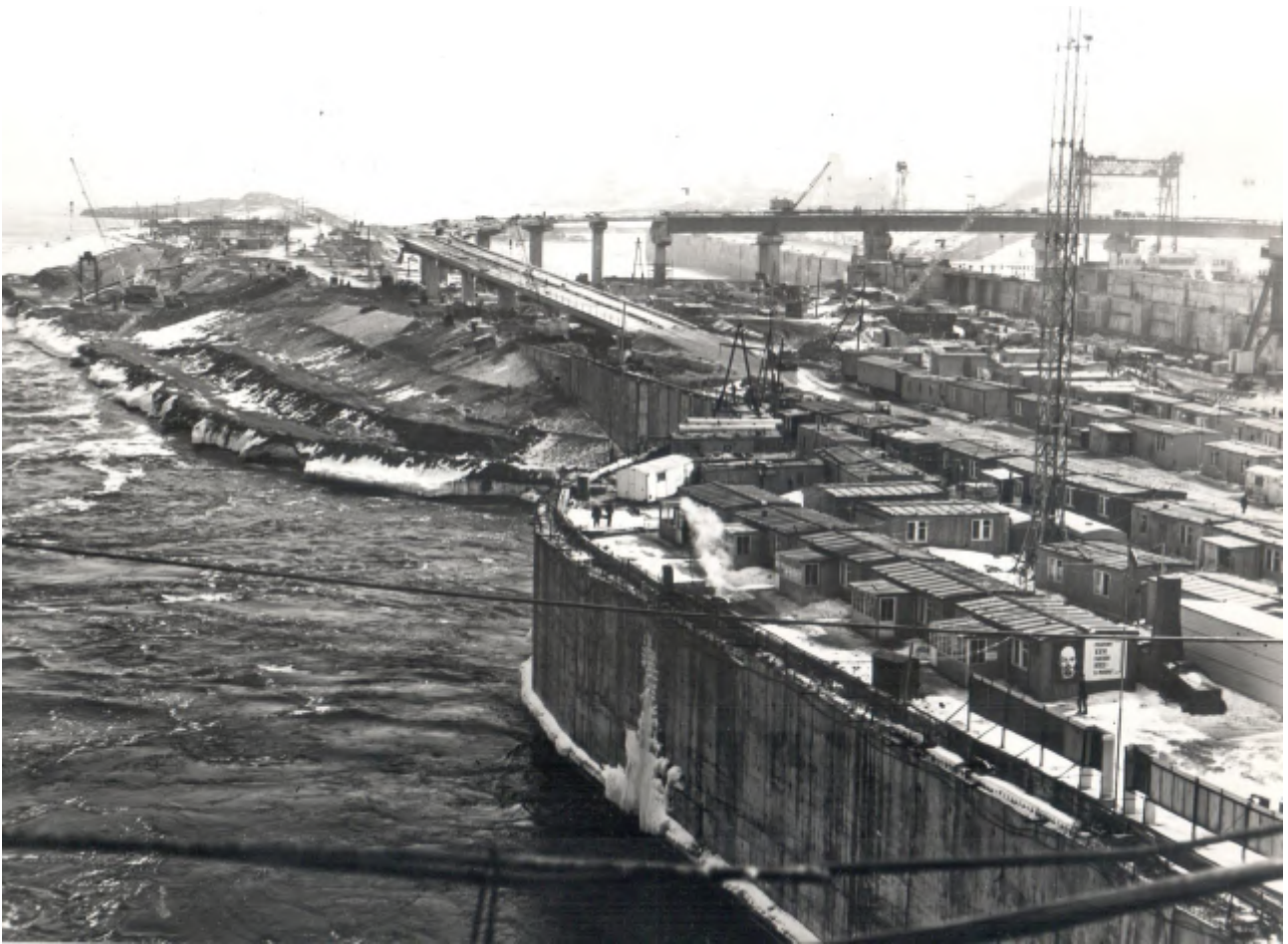
ГЭС. Службная автодорога. 1982 год.
