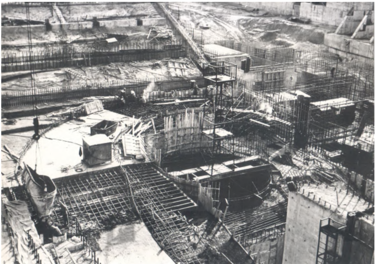
Здание ГЭС. Строительство статора агрегата №1. 1978 год.
