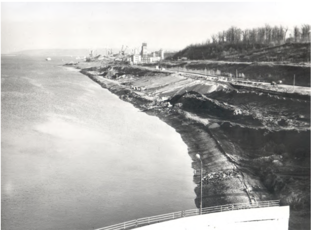
Поярусная планировка берега. На заднем плане – нижняя стройплощадка. 1979 год.
