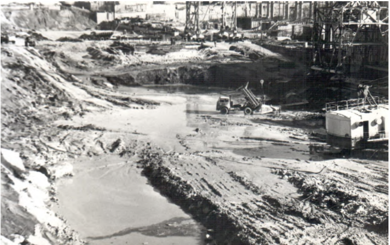
Котлован Здания ГЭС. Выемка грунта. 1977 год.
