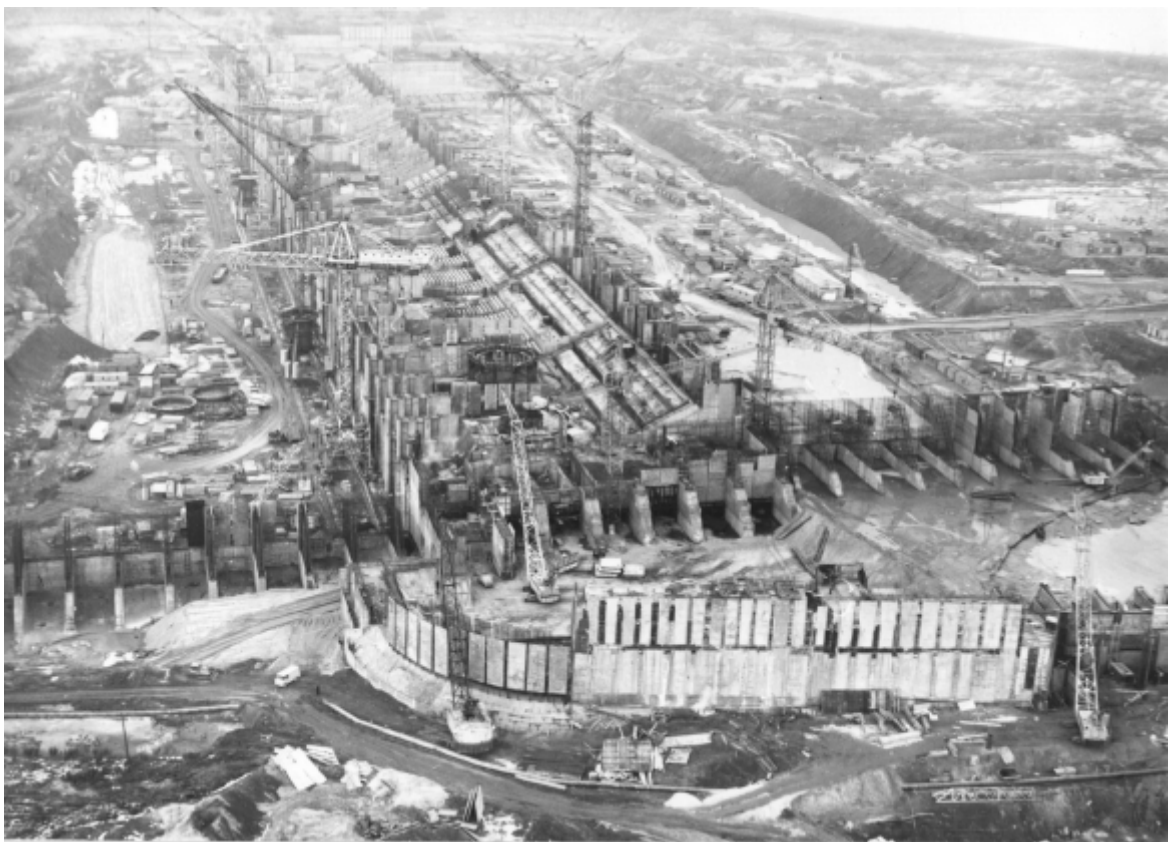
Здание ГЭС. Монтаж первого яруса. 1976 год.
