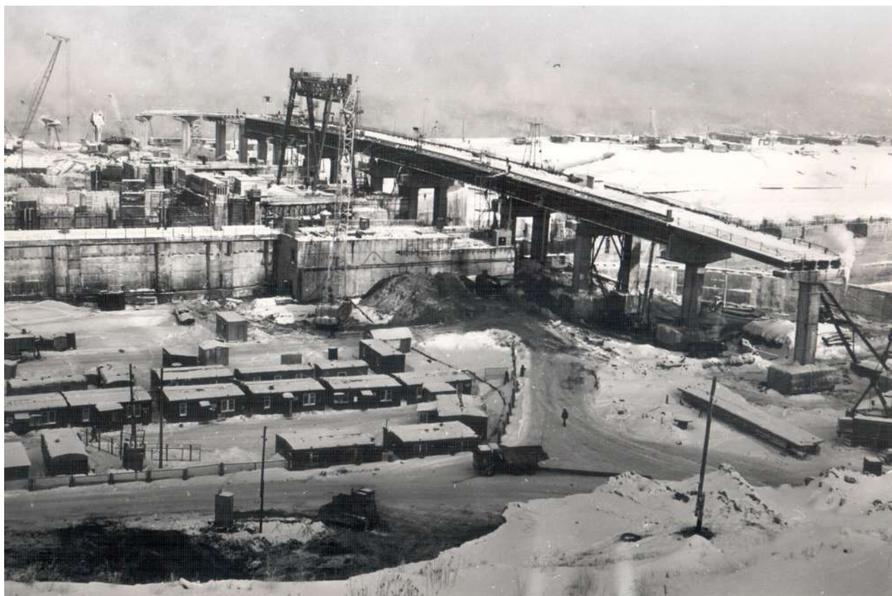
Нижняя голова шлюза. Строительство служебного моста. 1981 год
