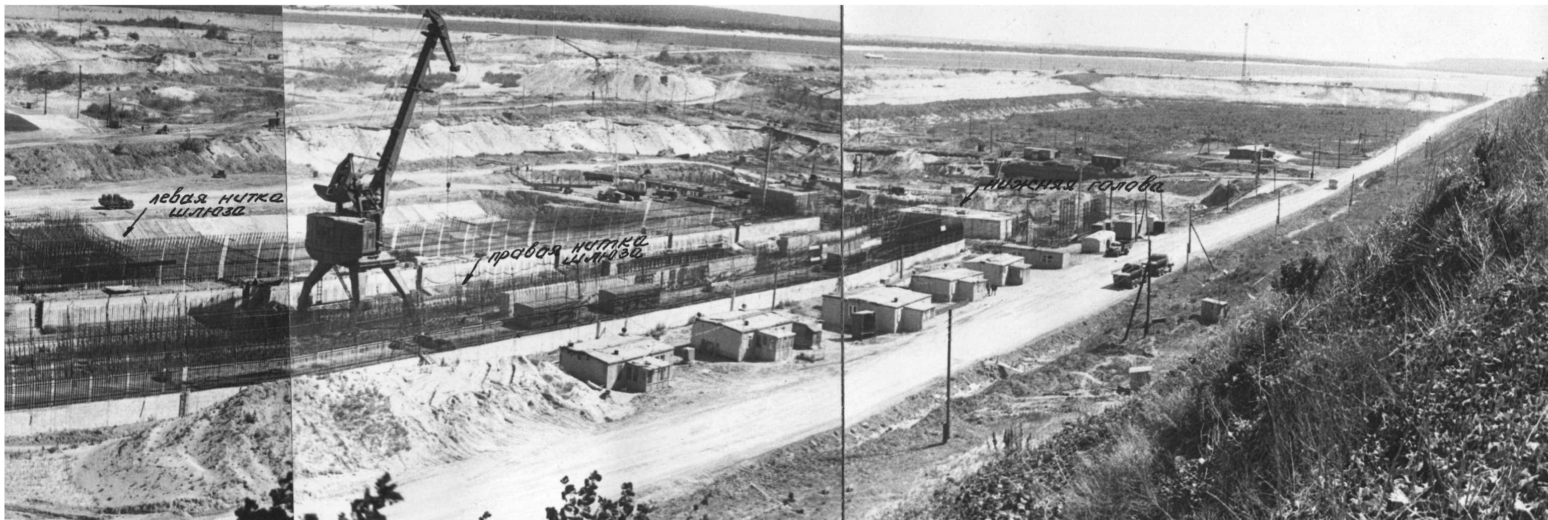
Строительство шлюза. 1973 год.
