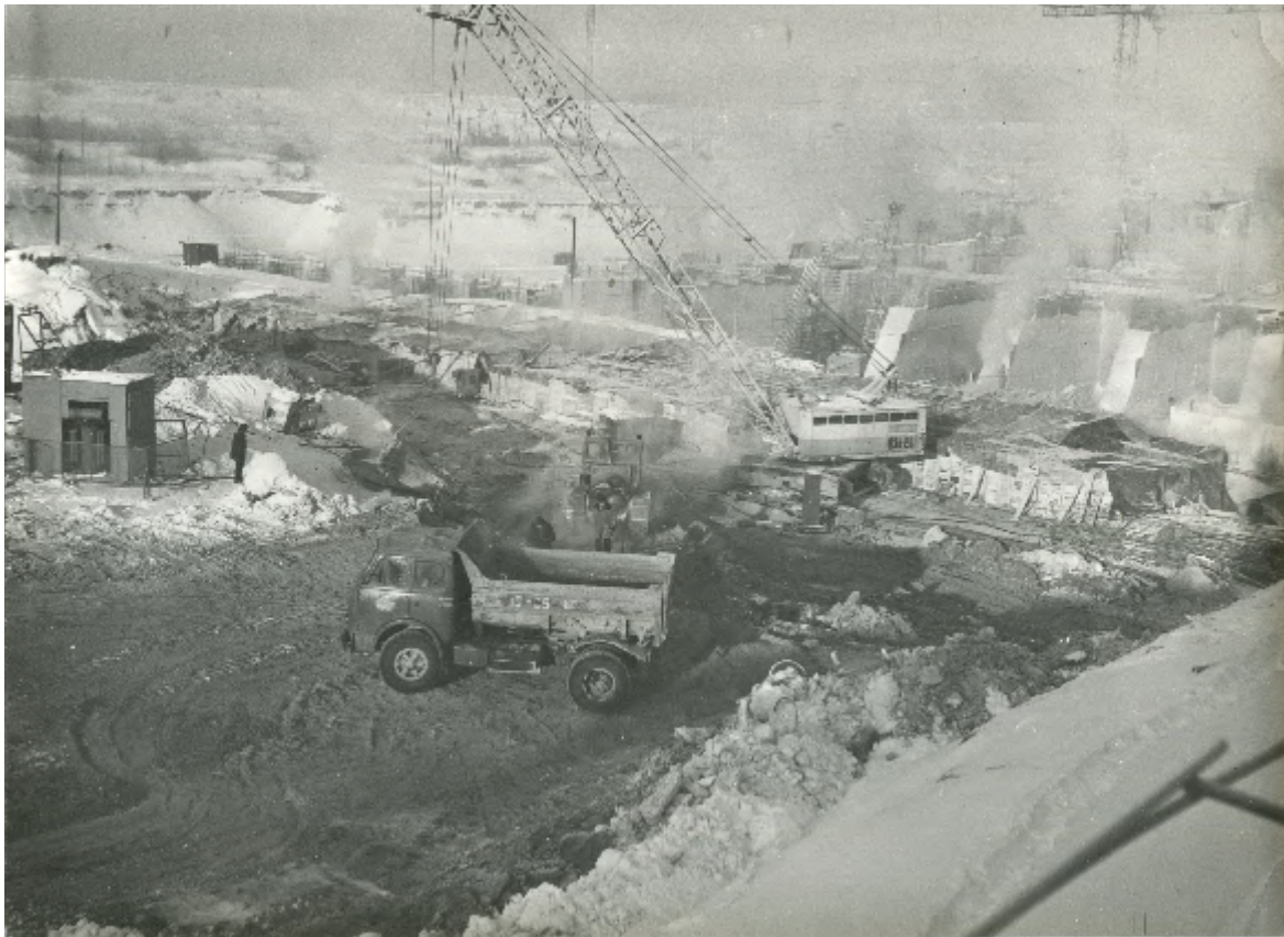
Котлован второй очереди. Выемка грунта. 1976 год.
