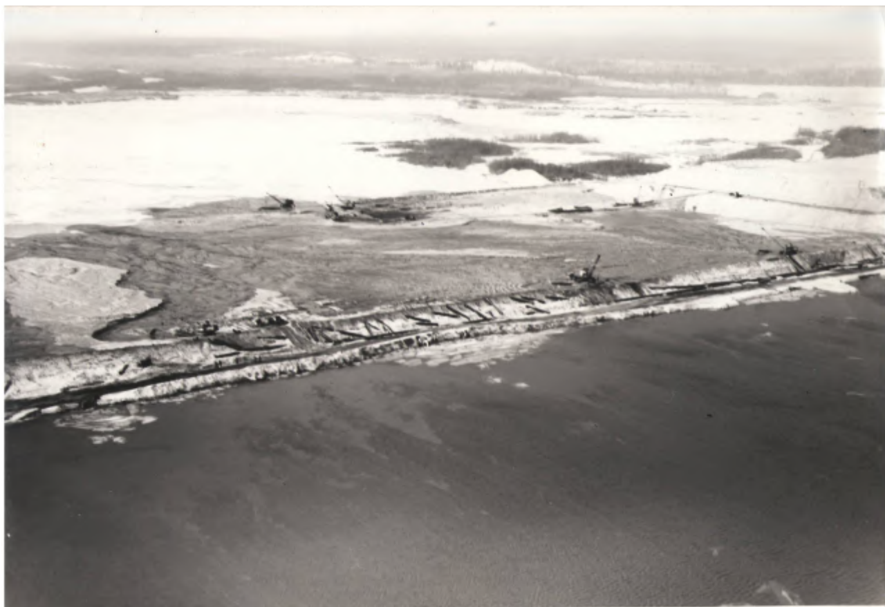
Намыв земляной плотины. 1980 год.
