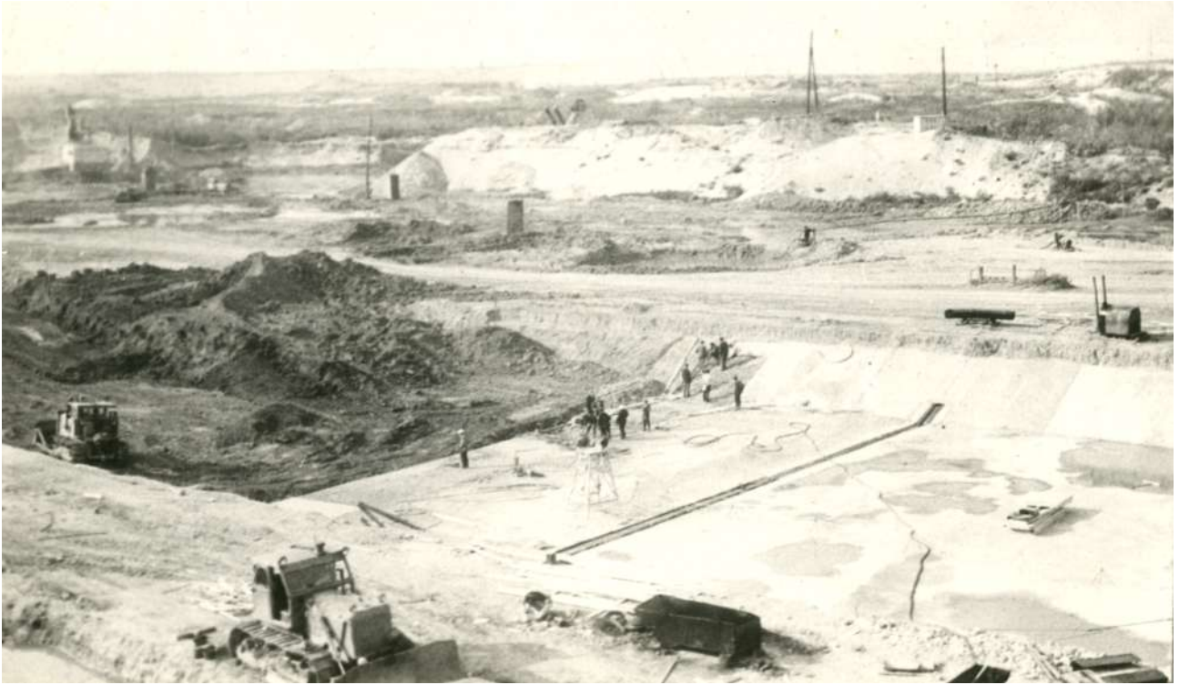
Шлюз. Правая нитка. Подготовка основания к бетонированию. 1973 год.
