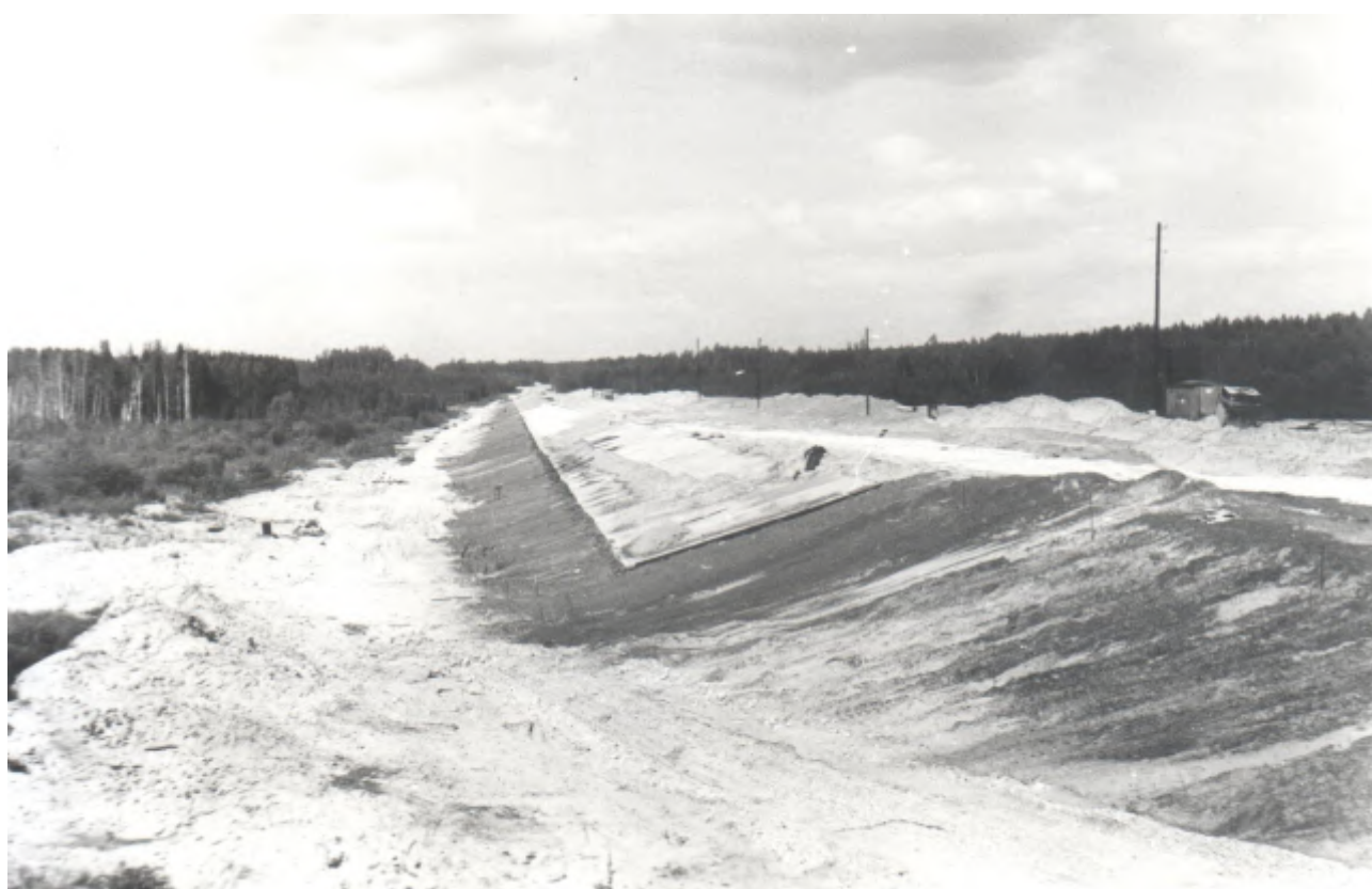
Земляная плотина. Верхний бьеф. Крепление откосов. 1980 год.
