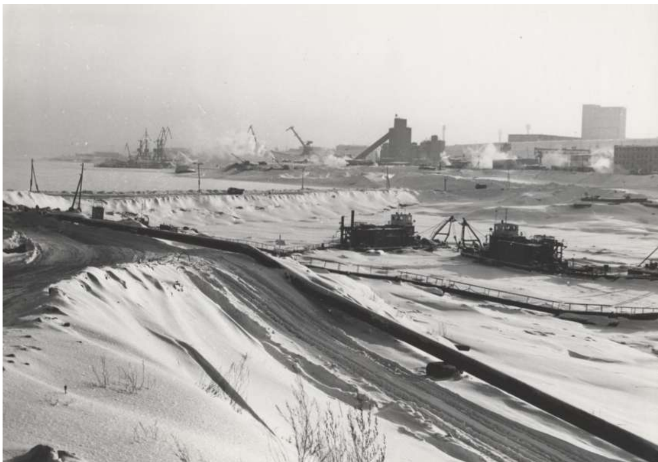
Котлован первой очереди. Откачка воды и осушение котлована. 1969 год.
