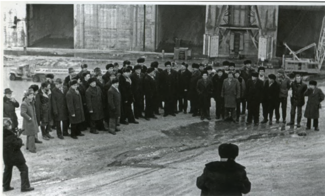
Перед затоплением котлована Чебоксарской ГЭС. 4 ноября 1980 года.
