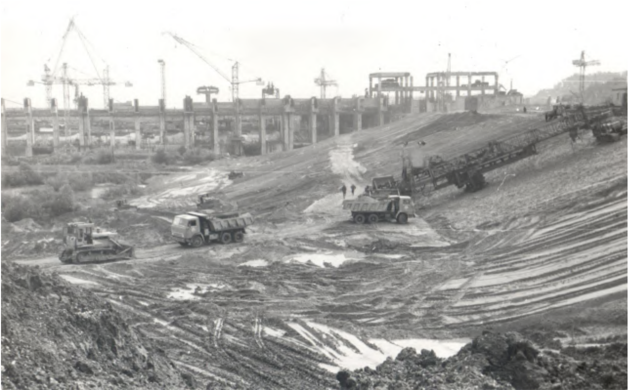
Сопряжение здания ГЭС с дамбой аванпорта. 1979 год.
