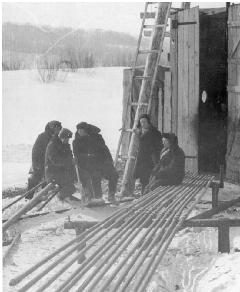
Ельниковский створ. Бурение глубокой скважины (250м) в русле Волги. 1960 год.
