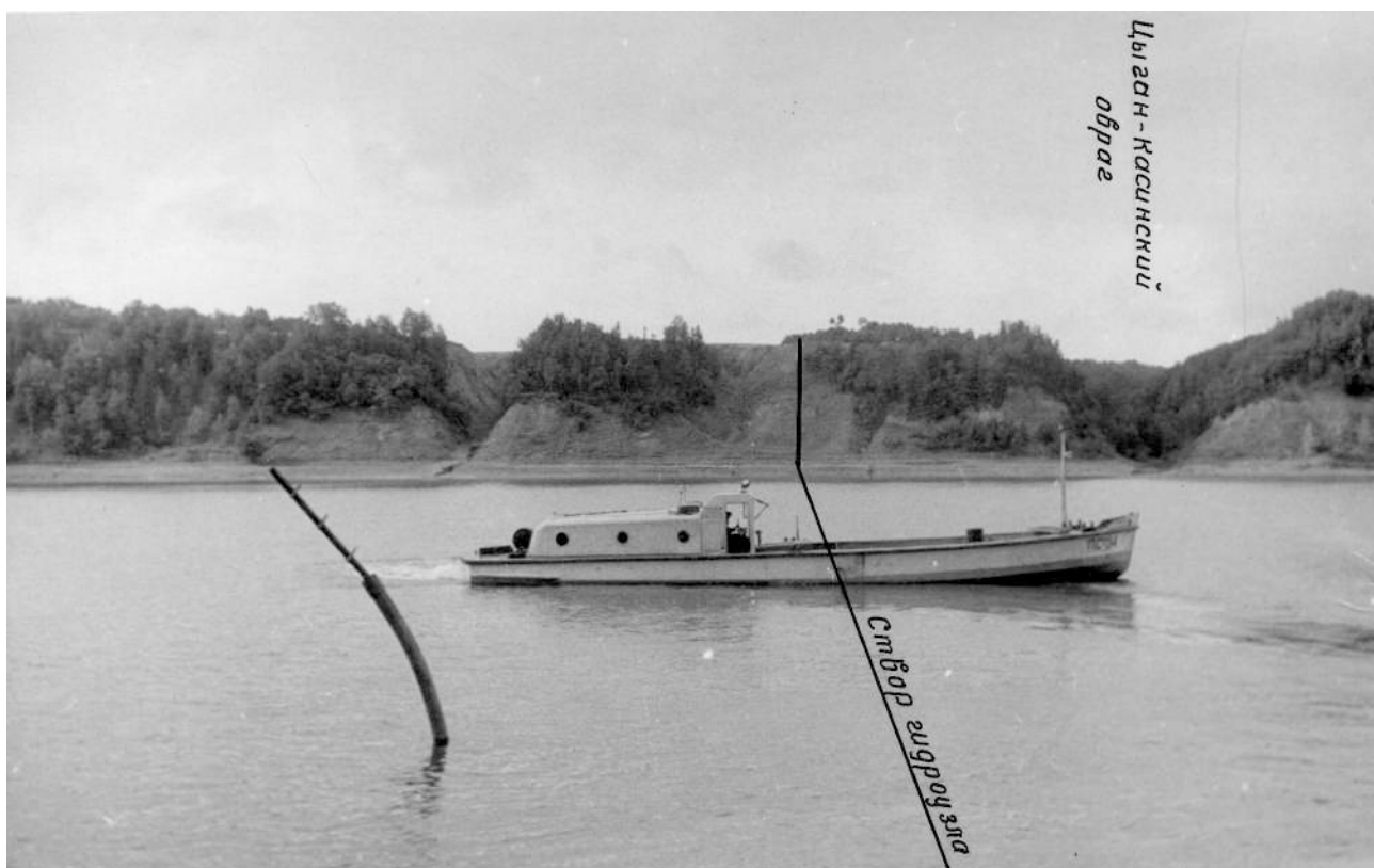
Река Волга после паводка. Ледяной массой согнут пьезометр. 1963 год.
