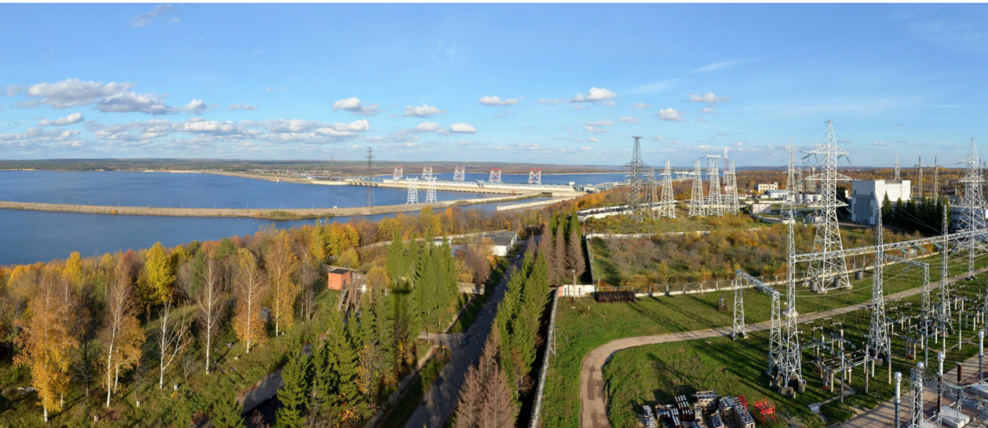
Современный вид на гидростанцию и ОРУ 500/220 кВ
