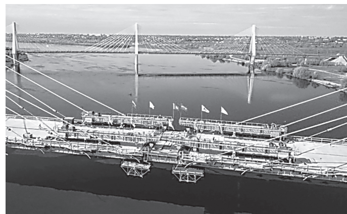
В июне должен открыться технологический проезд по новому вантовому мосту через Оку.
