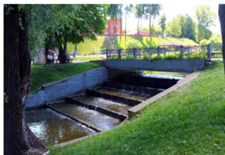
Рис. 6. Келарский пруд на реке Копнинке: а – общий вид; б – ступенчатый водосброс
