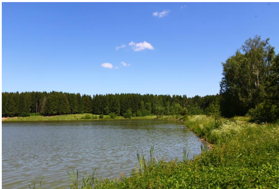
Рис. 5. ГТС плотины оз. Загорское море на р. Копнинке
