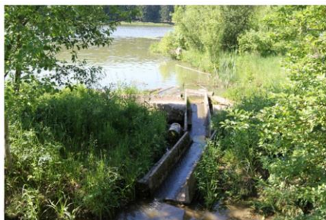
Рис. 7. ГТС Плотина озера Загорское море: а – быстроток, б – дорога по гребню плотины
