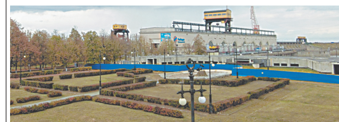
За 11 лет действия ПКМ прирост установленной мощности гидроэлектростанций РусГидро составил 580 МВт, что можно сравнить с появлением в составе энергохолдинга еще одной большой ГЭС. За это время были заменены или модернизированы 134 гидротурбины, 122 генератора, 95 силовых трансформаторов, а также более 10 тысяч единиц вспомогательного оборудования.
