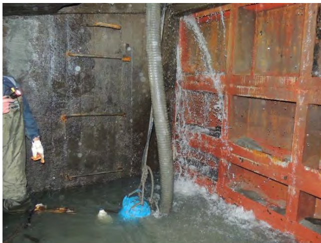
Рис. 7. Условия проведения обследований в отсасывающей трубе при дефектном уплотнении затвора
