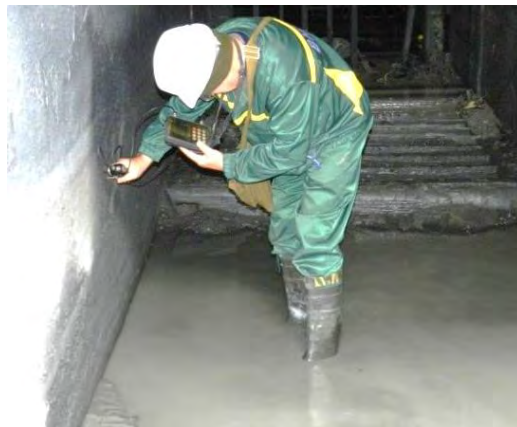
Рис. 12. Контроль прочности бетона ультразвуковым методом
