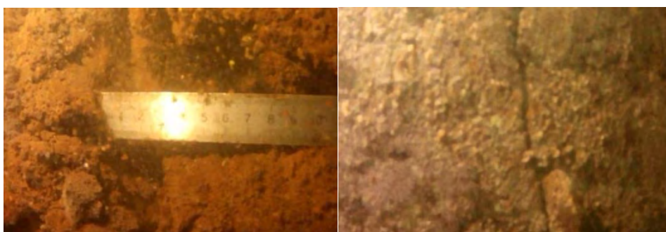
Рис. 3. Оценка ширины раскрытия межблочного шва под водой
