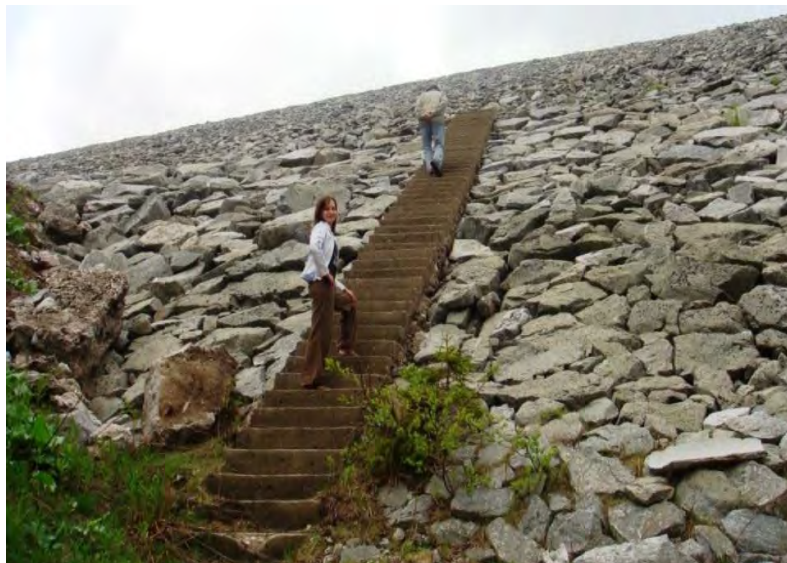
Рис. 8. Низовой откос каменно-земляной плотины Белмекен, защищенный плитчатыми каменными блоками
