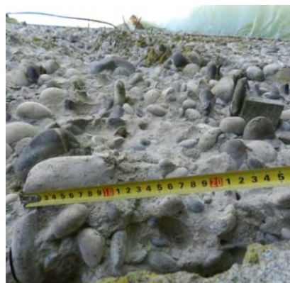
Рис. 2. Обнажение бетонной кладки при разрушении поверхностного слоя. Вид крупного заполнителя – гальки размерами до 100 мм
