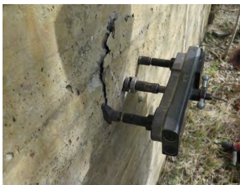
Рис. 10. Контроль прочности бетона методом отрыва со скалыванием
