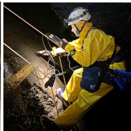
Рис. 13. Контроль прочности бетона ультразвуковым методом с использованием альпинистской оснастки
