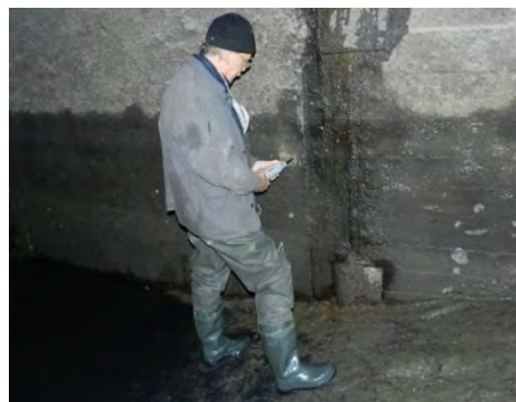
Рис. 11. Контроль прочности бетона механическим методом упругого отскока
