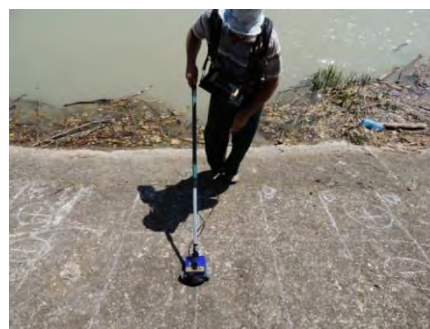
Рис. 16. Георадиолокационный поиск полостей под железобетонной облицовкой грунтового откоса
