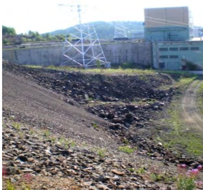
Рис. 7. Фрагмент участка низового откоса плотины Вилюйской ГЭС после 60-и лет ее эксплуатации
