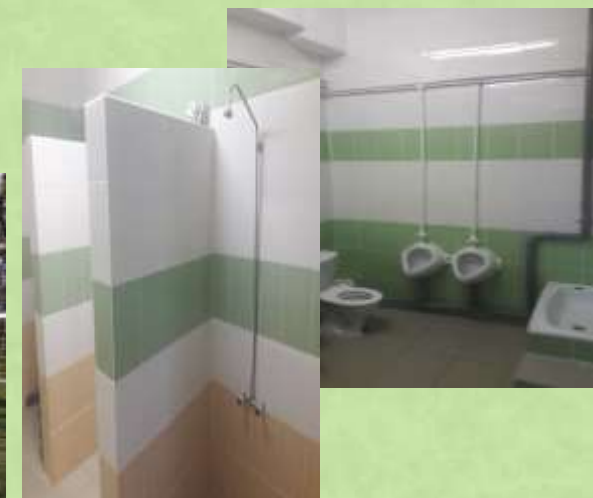
Проведен капитальный ремонт физкультурного, тренажерного и музыкального залов, душевой:
