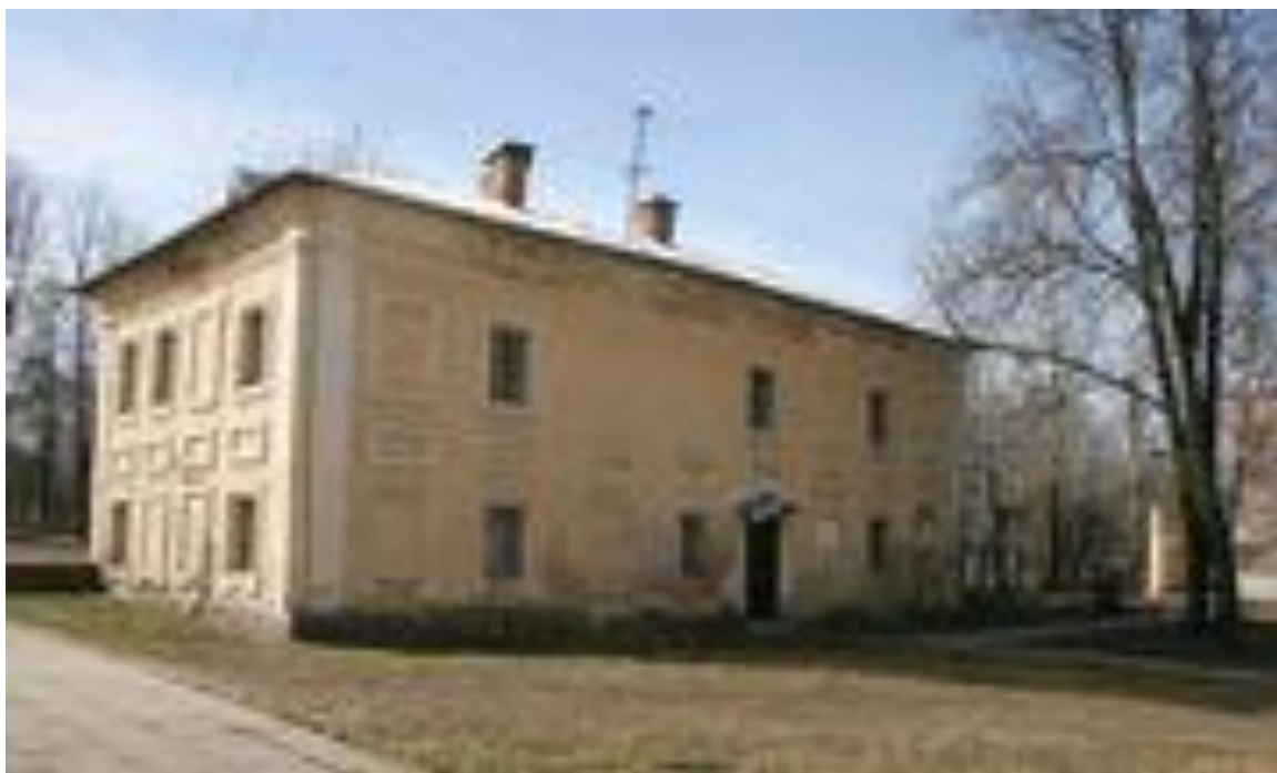
Сохранившаяся постройка, богадельня.
