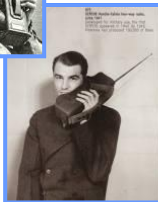
Портативный американский радиотелефон (1941 г.). Диапазон частот 3.5 — 6 МГц; дальность связи — 1,6 км; размеры — 92x400x136 мм; масса с батареями — 2,5 кг.
