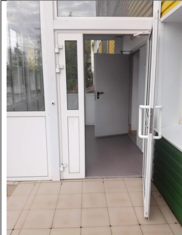
фото №5 входная площадка, дверь (входная)
