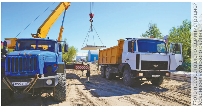
Сейчас специалисты занимаются подготовкой основания, укладкой нового дорожного покрытия, установкой бордюрного камня и обустройством тротуаров.
