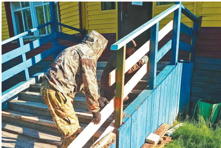
Ремонт крылец и пандусов – одна из приоритетных задач летнего благоустройства.
