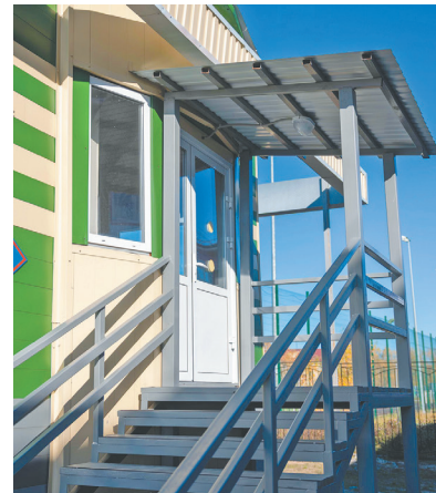
В музыкальной школе сделали вход с южной стороны – новое крыльцо, двери, навес.
