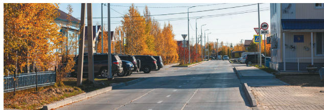
Улица Огнеборцев после капремонта.
