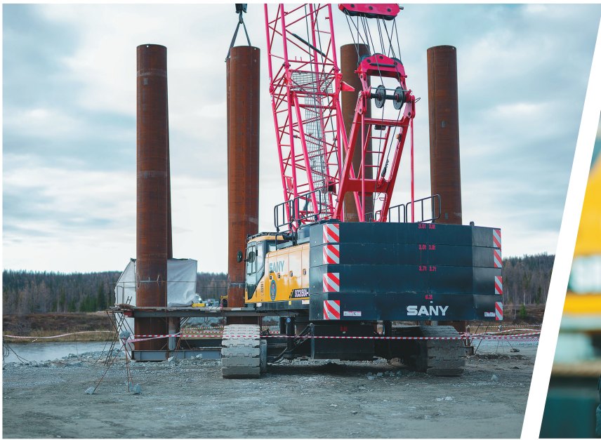
Каждую сваю для будущего моста через Собь погружают в землю на девять метров. Уже готовы восемь конструкций.
