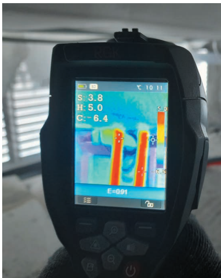
Работу термостабилизаторов изучают с помощью тепловизора
